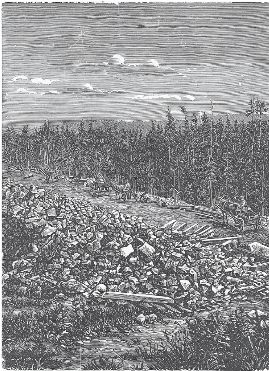
Устройство насыпи для желѣзной дороги на Уралѣ.
